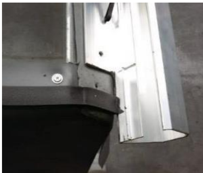
Rys. 56 Przykład podęcia profilu krawędziowego
