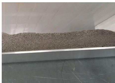
Rys. 34 Uszczelka rozprężna tuż po aplikacji
